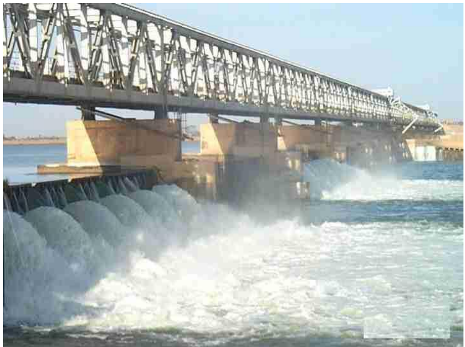
Barrage de Markala
